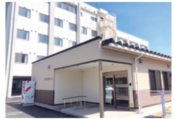
手前の施設は保育園、後ろの施設は5階建ての特別養護老人ホーム
